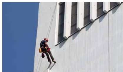
Industriekletterer bei der Installation von Taubenabwehrnetzen an einem 160 Meter hohen Turm.
