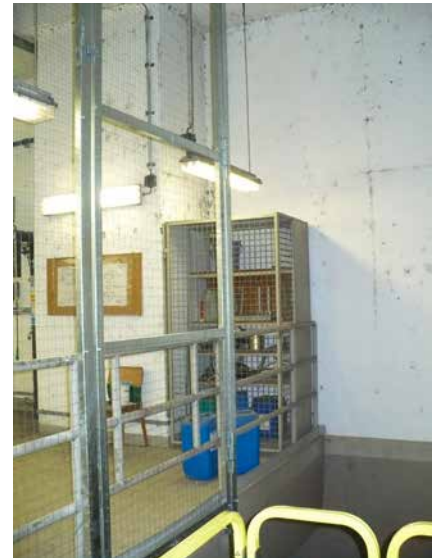
Vertikal angebrachtes Vernetzungssystem innerhalb einer Industrieanlage
